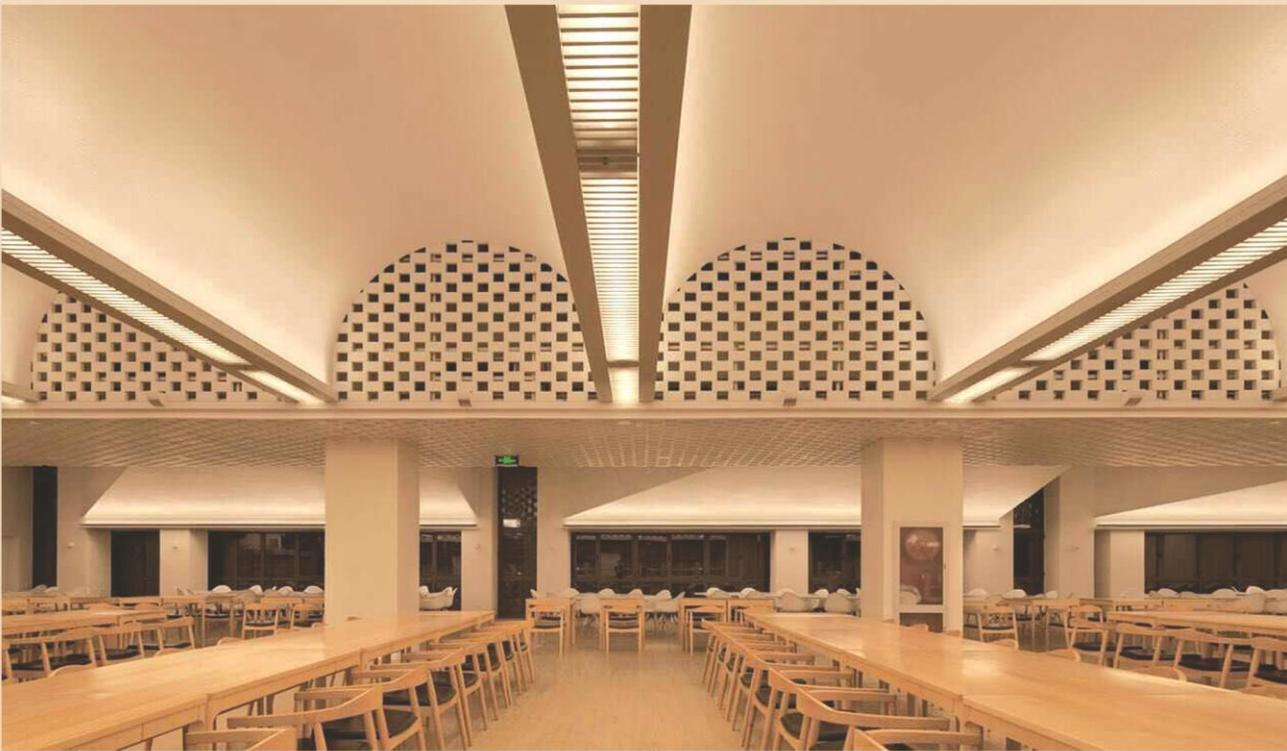
**声学措施：**经过声学设计和计算机模拟分析，最终确定墙面以及顶部采用白色砂岩环保吸声板面层鹏图处理装饰上可获得大面积无缝效果，风格简单大方，环保性能好，竣工后立即投入使用，防火A级。
